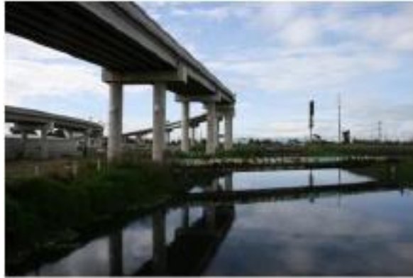
Figura 2.29 Canal de desagüe. Planta Lerma.
